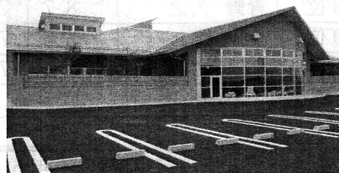
健康センターと駐車場
